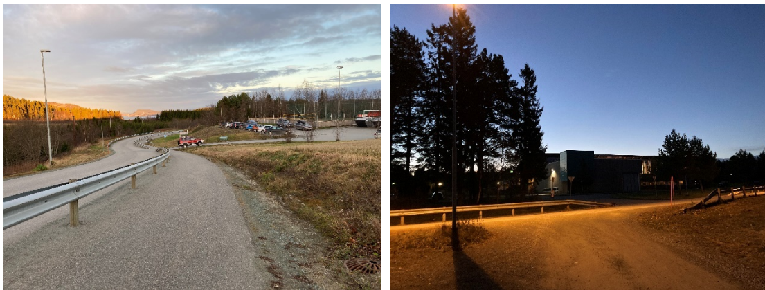
Figur 6 Avkjørsler til idrettsanlegg/bhg. (bilde til venstre) og til Brekkåsen skole (høyre) tatt fra motsatt side av Klemmets veg
